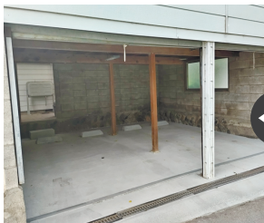
シャッターは電動化しコンクリートを打設雨返しを設置し使い勝手の良い車庫に様変わり
