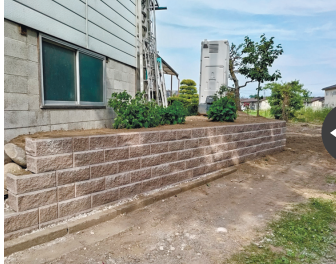
コンクリートを使用しない【ABSブロック】にて施工。施工も早く見た目もよくご主人大満足でした。
