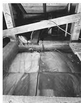
天井にはこれだけの断熱材を敷き詰めました
