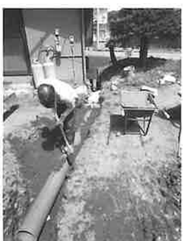
新たな樹脂管を施行中
