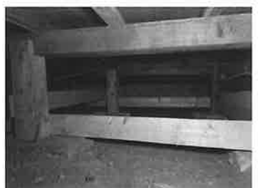
施工前の寒々しい床下
