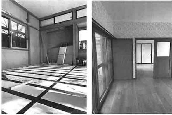
床にもしっかり断熱材が入り、バリアフリーのフローリングに
